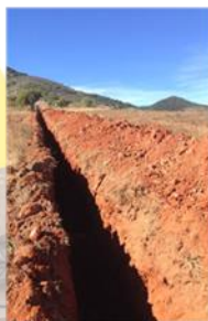
Construcción de Línea de Conducción de Agua Potable SAN JOSE DE RANCHOS Inversión $ 355,146.00 Beneficiarios 804 habitantes
