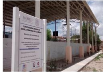
Construcción de Domo en Escuela Primaria Nicolás Bravo COL LA BLANCA
