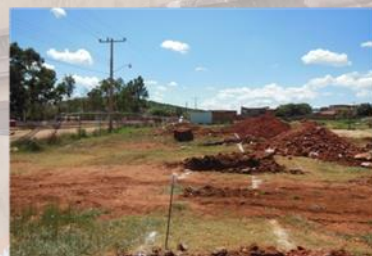
OBRA EN PROCESO
