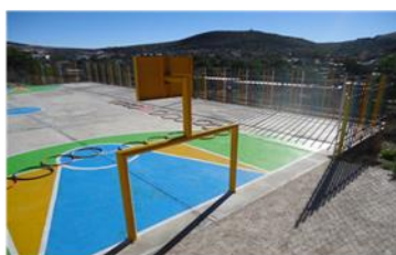
Construcción de Domo en Jardín de Niños María Marrufo CABECERA MUNICIPAL Inversión $ 346.624,00 Beneficiarios 110 habitantes
