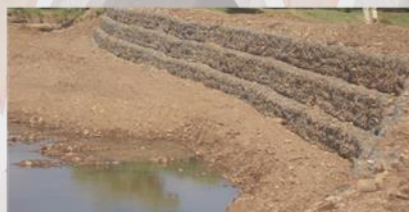
Adquisición de Gaviones para Construcción de Muro de Contención en Arroyo SANTA LUCIA Inversión $ 359,724.61 Beneficiarios 168 habitantes
