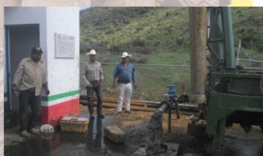
Rehabilitación de Pozo Profundo de Agua Potable SAN JOSÉ DE RANCHOS Inversión $ 303,223.00 Beneficiarios 804 habitantes
