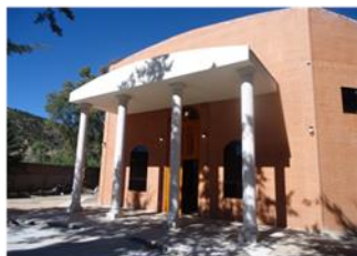
Construcción de Biblioteca Pública. Segunda Etapa VILLA INSURGENTES Inversión $ 1'200,000.00 Beneficiarios 1,660 habitantes
