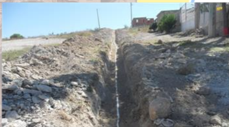
Ampliación y Rehabilitación de Sistemas de Agua Potable (Suministro de Tubería) COBERTURA MUNICIPAL Inversión $ 80,000.00
