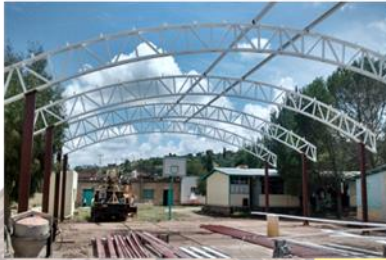
Construcción de Domo en Escuela Primaria Joaquín Amaro CORRALES
