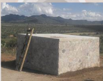
Equipamiento de Pozo Profundo de Agua Potable PROVIDENCIA DEL CARMEN Inversión $ 562,172.00 Beneficiarios 117 habitantes
