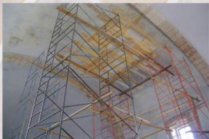
Rehabilitación de Cubierta del Templo de Tercera Orden del Conjunto Conventual de San Francisco
