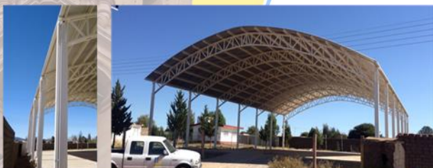
Construcción de Domo en Salón Ejidal MATEO GOMEZ Inversión $ 672,800.00 Beneficiarios 476 habitantes
