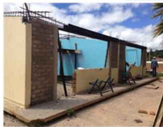
Rehabilitación de aula en Primaria DOROTEO ARANGO Inversión $ 242,247.40 Beneficiarios 324 habitantes
