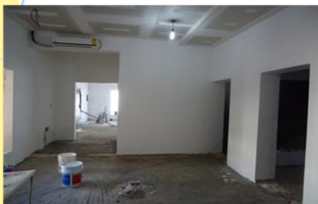
OBRA EN PROCESO
