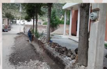
Construcción de Pórtico Biblioteca Pública VILLA INSURGENTES Inversión $ 166,600.00 Beneficiarios 1,660 habitantes
