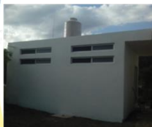
Construcción de Sanitarios en Jardín de Niños Juana de Asbaje DOROTEO ARANGO Inversión $ 210,833.00 Beneficiarios 324 habitantes
