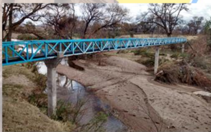
Terminación de Puente Peatonal COL ORION Inversión $ 21,055.00 Beneficiarios 130 habitantes
