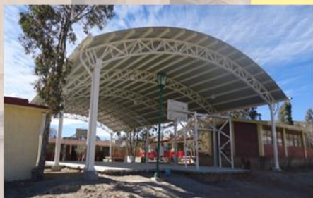
Construcción de Domo en Escuela Primaria Miguel Auza COL AMPL ADOLFO LOPEZ MATEOS Inversión $ 520.000,00 Beneficiarios 402 habitantes
