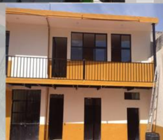
Construcción de Aula y Corredor en Esc. Prim. Liceo Bracho CABECERA MUNICIPAL Inversión $ 235.391,00 Beneficiarios 510 habitantes
