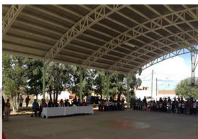
Construcción de Domo en Escuela Primaria Miguel Hidalgo COL HIDALGO Inversión $ 672.800,00 Beneficiarios 2.373 habitantes
