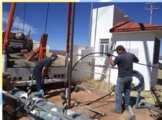
Ampliación y Rehabilitación de Redes de Agua Potable (Suministro de Tubería) COBERTURA MUNICIPAL Inversión $ 200,000.00
