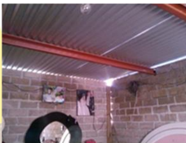
Mejoramiento de Vivienda Techos COBERTURA MUNICIPAL 220 Apoyos Beneficiarios 1,100 habitantes
