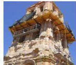
**Observaciones:** Se intervendrá el tercer cuerpo de la Torre del Templo Parroquial, consistente en la reposición de piezas de cantera, así como, la consolidación e inyección de grietas de todo la cantería, entre otras cosas.
