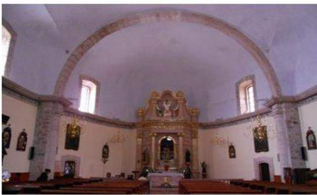
**Descripción:** Restauración de la Bóveda por intradós, se realizaron trabajos de: inyección de grietas, retiro de aplanados y pintura vinílica existente y la restitución de los mismos; limpieza, re nivelación y sustitución de piezas de cantera según se requiera.
