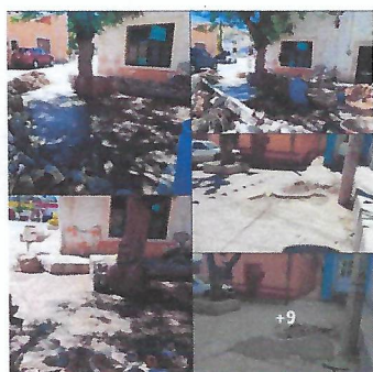
➤ Bacheo en la calle González Ortega y los Angeles, colonia la Pila.
