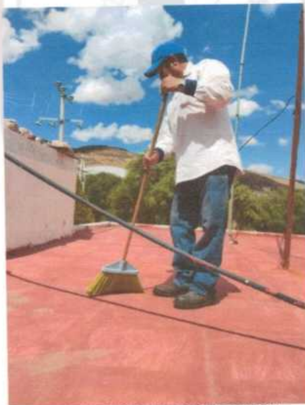
SE DIO MANTENIMIENTO A TECHO DE LA OFICINA
