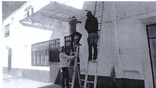
Colocando plafón de oficinas de Ómnibus
