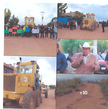
➤ Inicio de trabajos de mantenimiento en el camino a Ejido Independencia.
