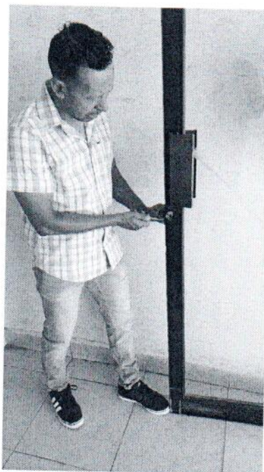
Mantenimiento a cerradura de puerta principal
