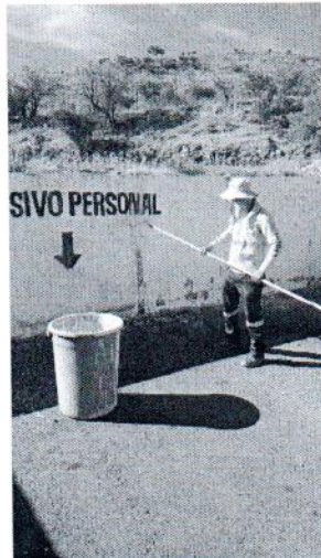
Mantenimiento a muro perimetral
