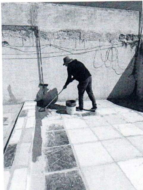
Se impermeabilizo parte de la azotea
