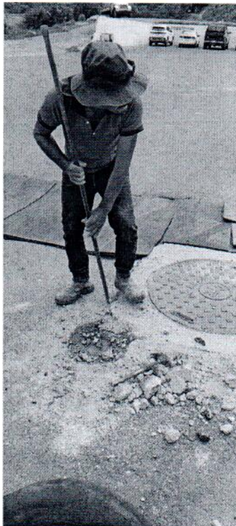
Colocación de material metálico para delimitar entrada al área de andenes
