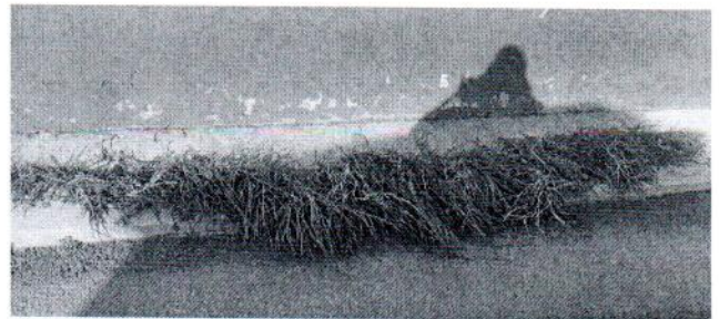
Quitando hierba del área de entrada de andenes
